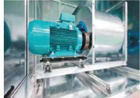
Fig 26: Fan Motor Assembly
