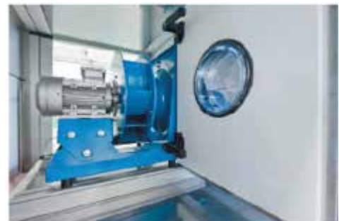
Fig 26: Plug Fan Assembly
