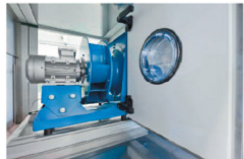
Fig 26: Plug Fan Assembly
