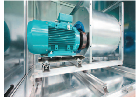
Fig 26: Fan Motor Assembly
